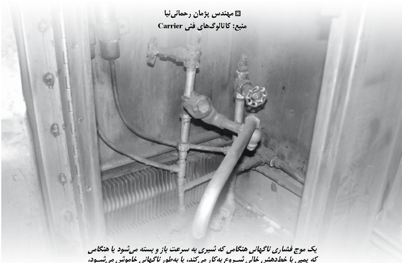
یک موج فشاری ناگهانی هنگامی که شیری به سرعت باز و بسته می‌شود یا هنگامی که پمپی با خوددهش خالی شروع به کار می‌کند، یا به طور ناگهانی خاموش می‌شود، می‌تواند به وجود آید. این پدیده نتیجه‌ی یک تغییر ناگهانی در سرعت جریان سیال در ترکیب با مشخصات لوله کشی است. این موج ناگهانی و ضربه‌ای بدوسیله‌ی یک سری از صدای ای‌تی‌سی خربرات چکش آشکار می‌شود که به عنوان ضربه قوچ آب<sup>۱</sup> شناخته می‌شوند که می‌تواند دارای بزرگی کافی برای ایجاد صدمات و آسیب‌های بیجده و فاجعه‌آور درون سیستم لوله کشی باشد.
